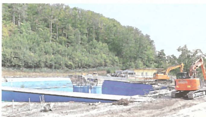
Einer Großbaustelle gleicht derzeit das Waldseebadareal. Foto: StVw
