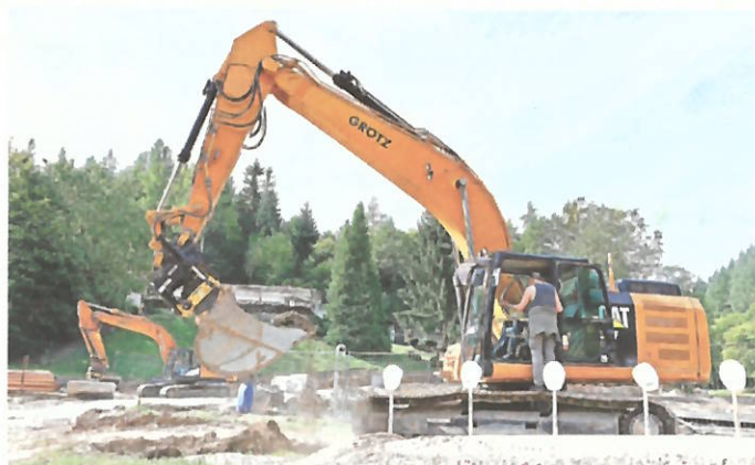
Oberbürgermeister Christof Florus nimmt den obligatorischen Baggerbiss vor. Foto: StVw
